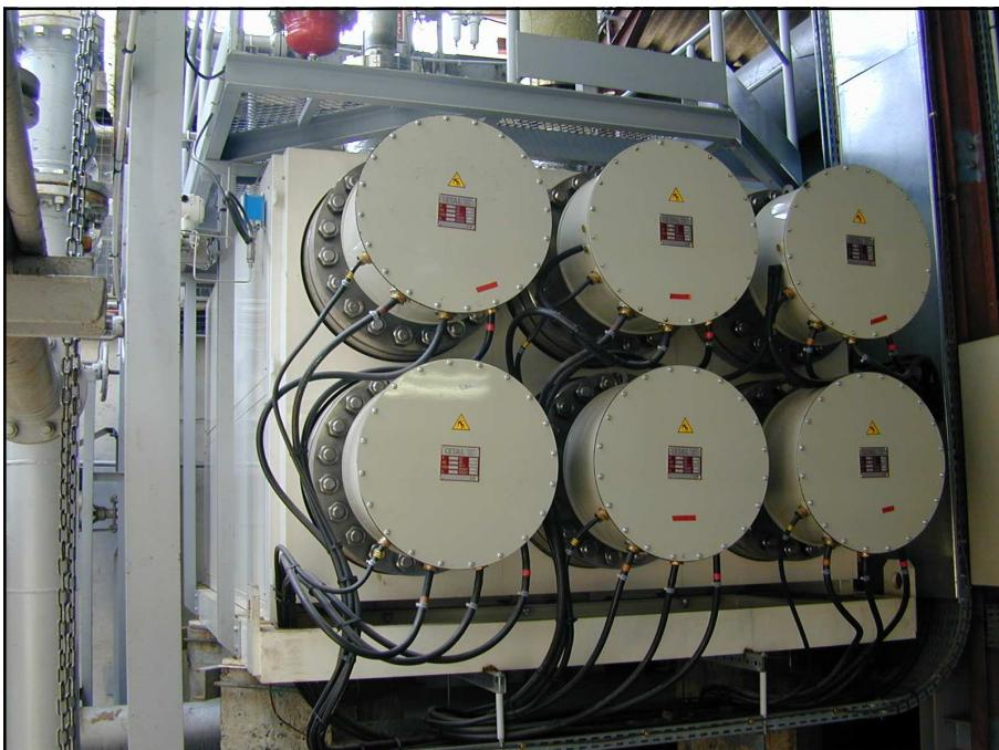
Réchauffeur d'Air électrique 2000 Kw, piloté par thyristors, pour chauffage d'air à 600°C sur banc d'essai aéronautique /
