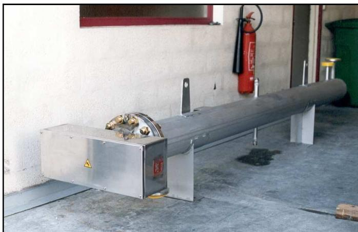
Réchauffeur Antidéflagrant EExe, 140 Kw de TEG avec armoire de puissance , pour extrusion de fibres polyester/
