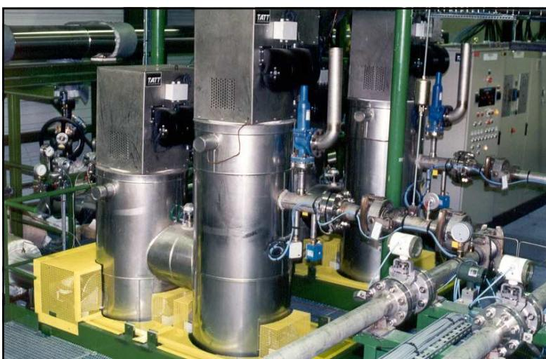
2 Surchauffeurs électriques 1100 Kw d'Air chaud à 750°C, 50 bars, avec cannes THP, construit selon CODAP, pour banc d'essais de composants aéronautiques dans le cadre du programme RAFALE de DASSAULT /
